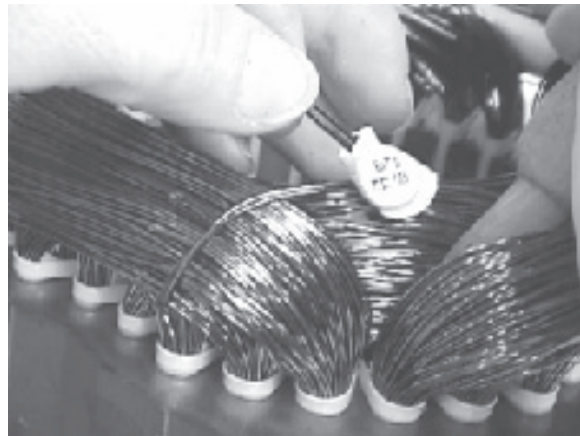
Figura 5.5 - Instalação do termostato na cabeça da bobina
