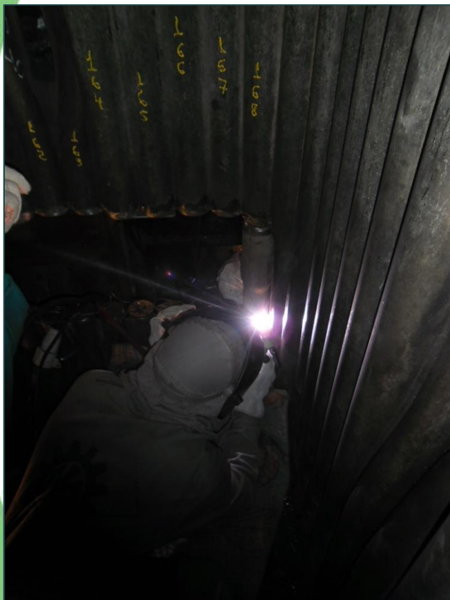
Detalhe da execução de soldagem
