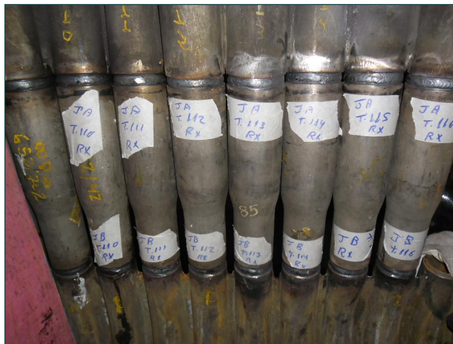
Trecho acoplado e solda de raiz finalizada
