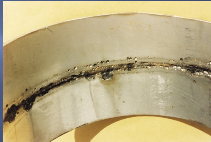
Corrosão em torno do cordão de solda com formação de pites ou alvéolos
