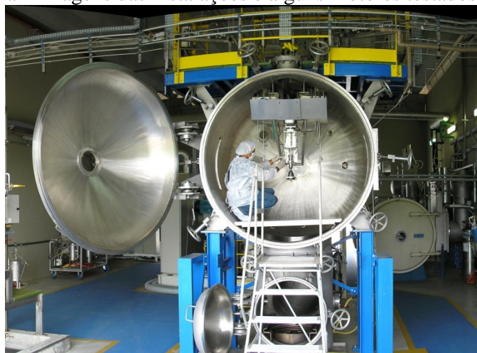
Instalação de propulsor na câmara de vácuo principal.
